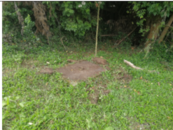
Foto N°2. Estado del sellamiento pz-11-0154
